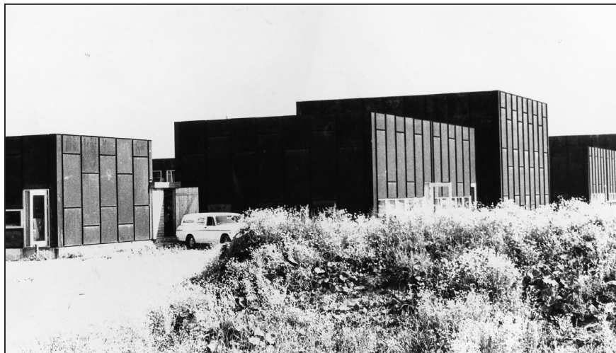
Byggeriets ydervægge blev beklædt med syrebehandlede plader af corténstål, som gav bygningerne et rustent udseende. Ballerup Museums billedsamling.
