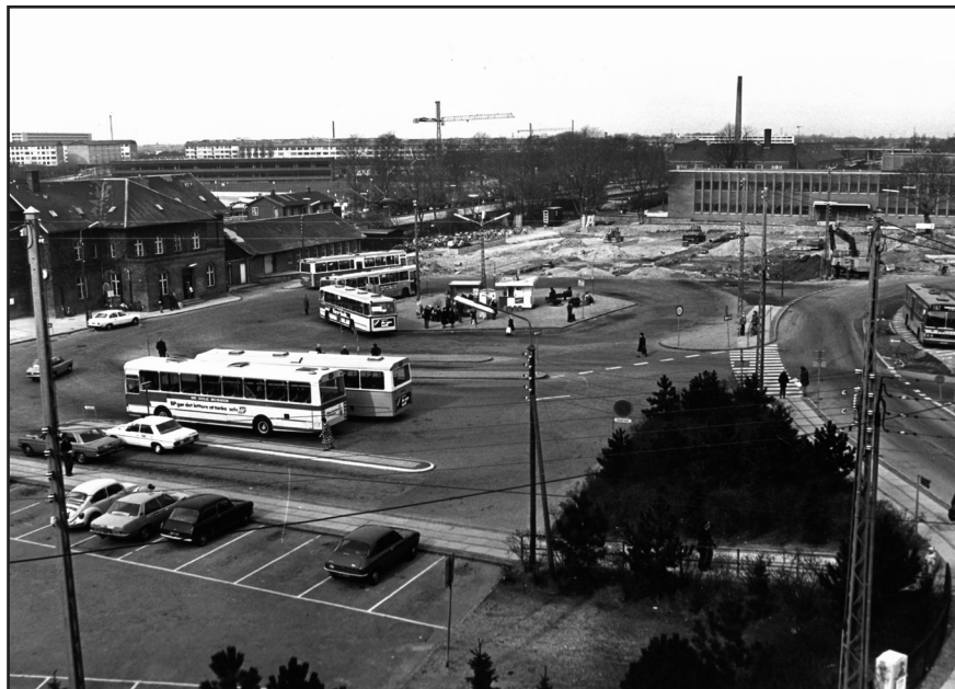
Anlæggelsen af Banegårdspladsen, 1977.
